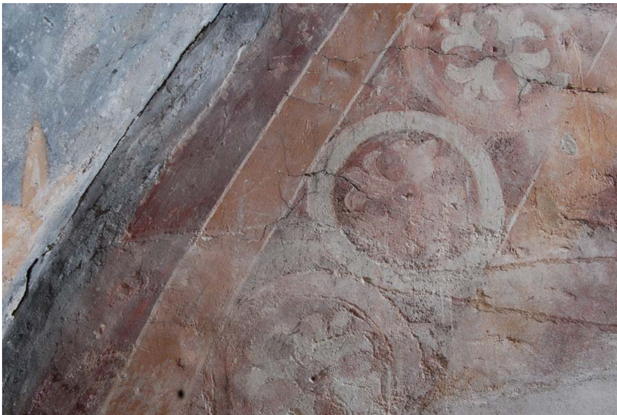
Korets västvägg med passarhål och inristningar efter cirkelslag i det nedre puts-skiftet. Foto 2007.
